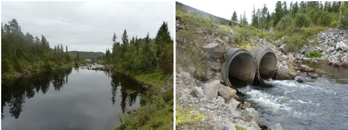
Figur 9. Frå utløpet av Førsvatn. Røyra under riksveg 42 kan truleg forserast av fisk når vassføringa er bra. Det same gjeld røyra under ein mindre veg lenger ned.
