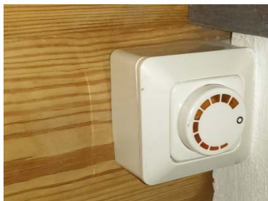
Bryter for vifte vedovn og peis, må bruke ved fyring og når kjøkkenvifte er i bruk.
