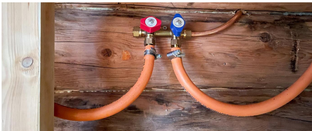
Ventiler under gassbluss og kjøleskap, en til hver av apparatene.
